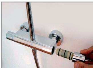
Снимите существующий картридж и ручку регулировки температуры
